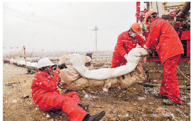
1月23日,大年初二,山东省东营市,胜利油田孤岛D24X29注汽现场,胜利日报记者王国章拍摄值班人员冒雪加固注汽管网保温棉。 盖振峰摄
