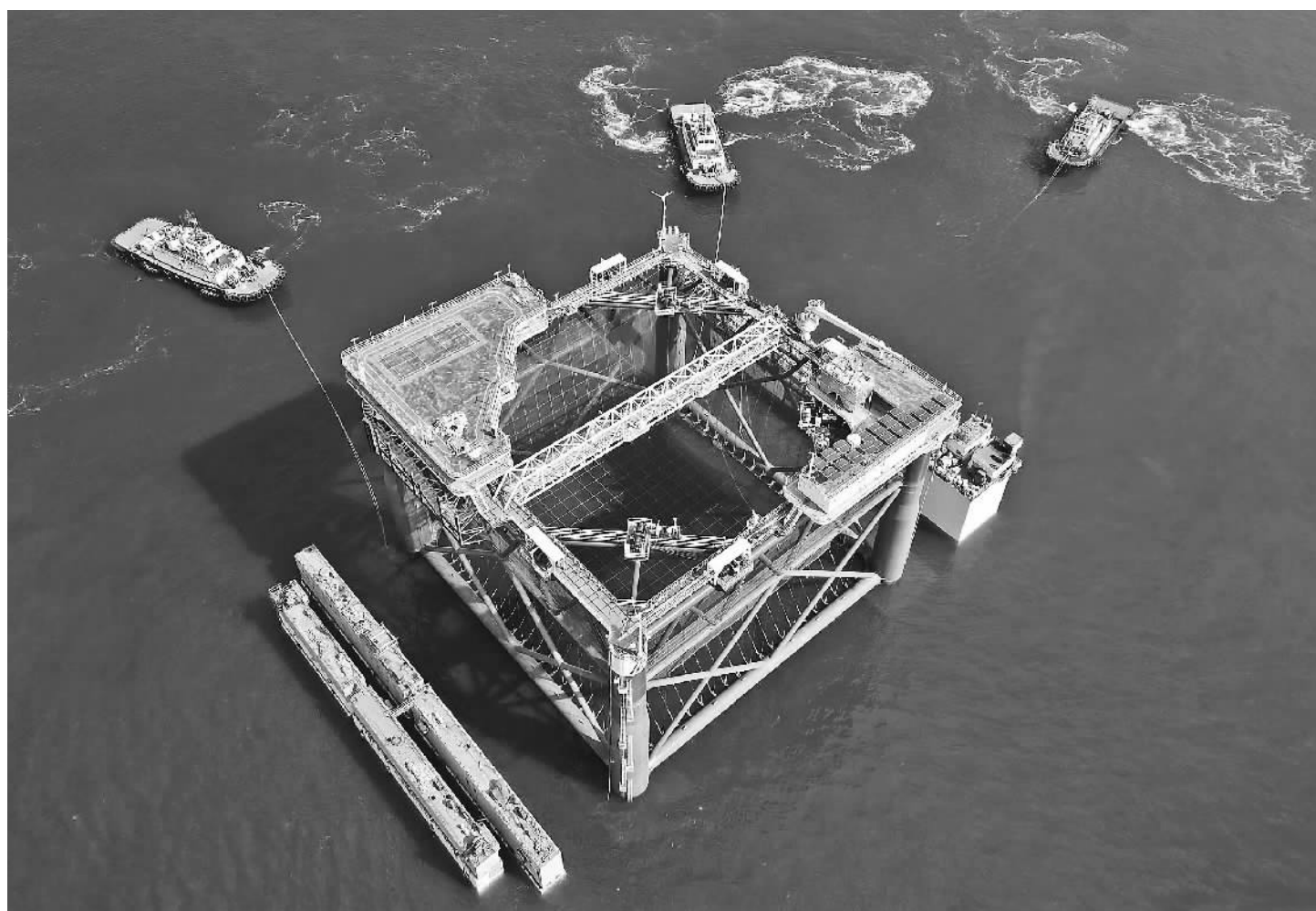
3月19日,大型深远海智能网箱平台“经海005号”在山东烟台长岛海域安装成功。“经海005号”长宽各68米,养殖包围水体达9.4万立方米,搭载了智能监测、自动投喂、自动洗网等设备,可以让鱼群在类野生环境中生长,年产渔获可达1000吨。
